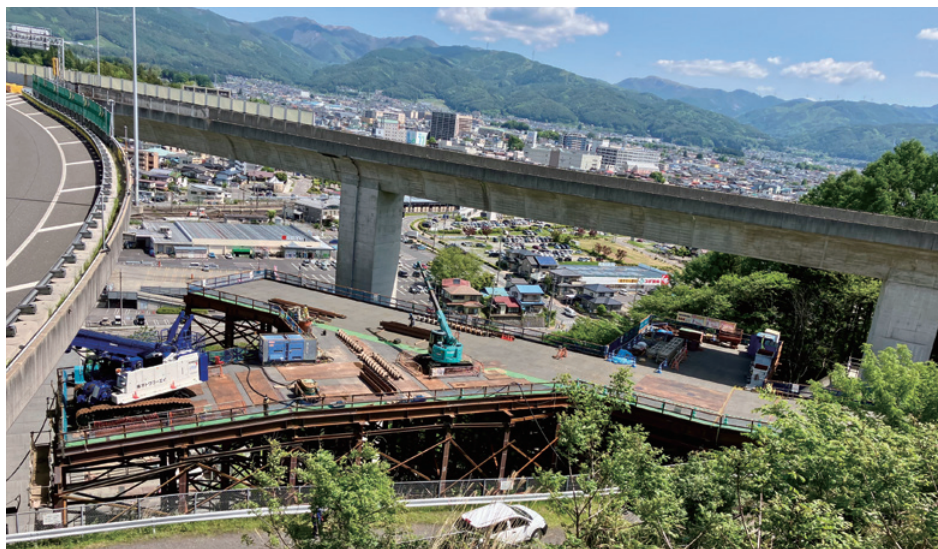
長野自動車道 岡谷高架橋改良工事
