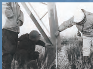
1959 新潟地盤沈下調査
