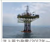
洋上風力発電(2017年~)
