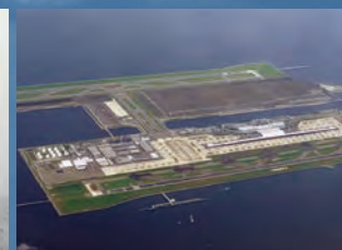
1982 関西国際空港土質調査
