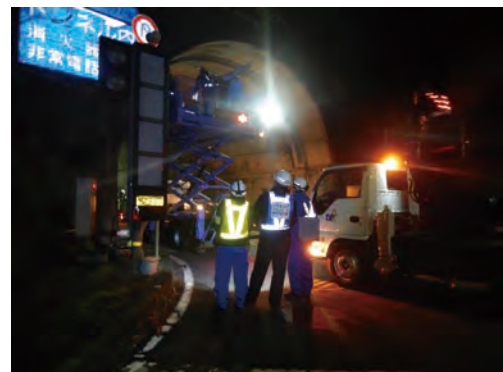
トンネル構造物点検の様子 ▲
