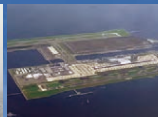
1982 関西国際空港土質調査
