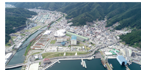
釜石東部地区空撮（2019年7月撮影）
