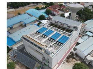
完成した上水道施設
