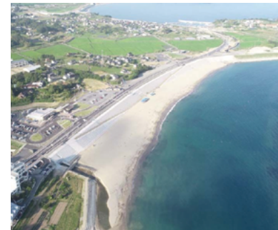
東日本大震災により甚大な被害を受けた 大谷海岸の砂浜再生まちづくり事業 (宮城県気仙沼市)
