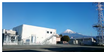
静岡ガス&パワー富士発電所
