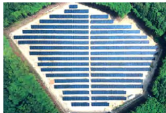
北関東エリアにおける高圧太陽光発電所（2024年7月運転開始）
