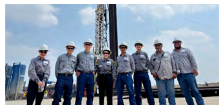
シェールガス井戸掘削現場
