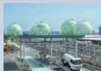
東邦液化ガス(株) 名港LPG基地
