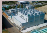
四日市発電所
