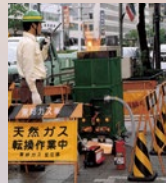
名古屋駅周辺の天然ガス転換作業
