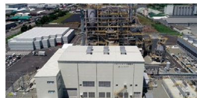
「八代バイオマス発電所」(2024年6月運転開始)
