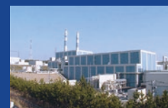
志賀原子力発電所2号機
