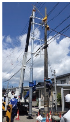
電柱元位置建替車両に電線を仮に移線した様子
