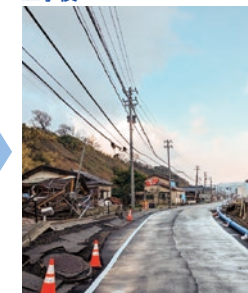
能登半島地震後の電柱建替え工事前後の様子
