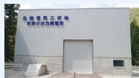
木本小水力発電所
