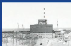
富山火力発電所1号機
