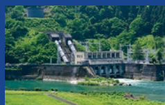
神通川第一発電所(水力)
