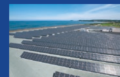
三国太陽光発電所
