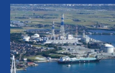
富山新港火力発電所LNG1号機
