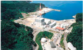
島根原子力発電所1号機
