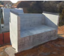
大田静間道路跨道橋(島根県)におけるコンクリート混和材(エコパウダー)
