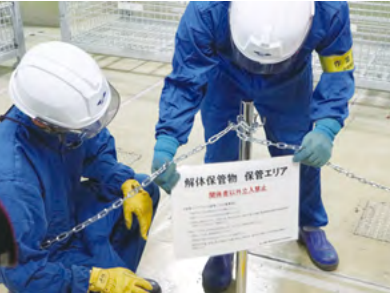
(第2段階準備作業)解体保管物の一時的保管エリアの設置
