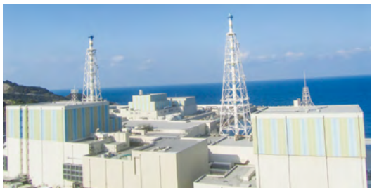
島根原子力発電所
