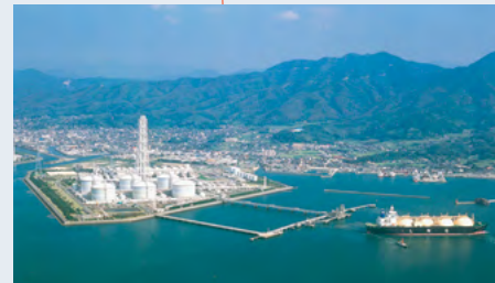
柳井LNG基地
