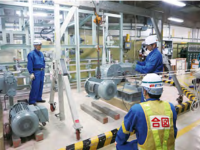
(第2段階作業)液体ボイズン系設備の解体撤去作業
