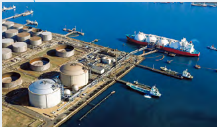
水島LNG基地
