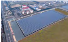
福山太陽光発電所
