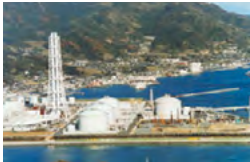
柳井発電所(LNG火力)
