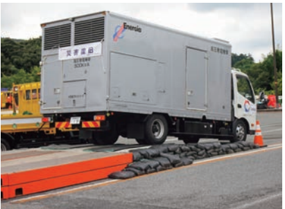
西日本高速道路(株)との緊急即応訓練 (2022年9月:高圧発電機車の通過訓練)
