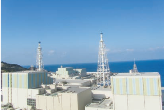
島根原子力発電所
