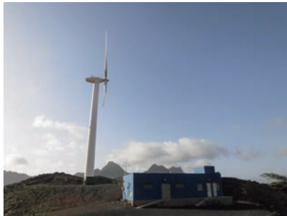
カーボベルデ国の風力発電所 (外観)
