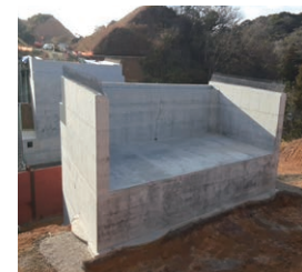
大田静岡道路 跨道橋における コンクリート混和材 (エコパウダー)
