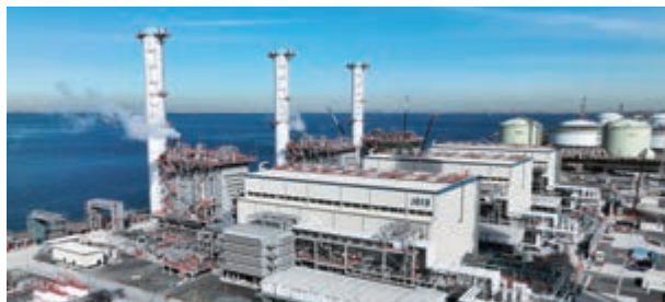
リプレース工事が完了した姉崎火力発電所新1号機の運転を本年2月から開始
