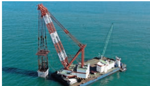
福島第一原子力発電所の沖合において放水口ケーソン据付作業を実施
