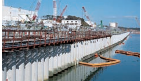
昨年10月に閉合作業が完了した海側遮水壁
