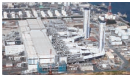
MACC II (More Advanced Combined Cycle II) を導入し営業運転を開始した川崎火力発電所2号系列第2軸
