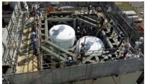
柏崎刈羽原子力発電所7号機の地上式フィルタバント設備のヨウ素フィルタ据え付け工事
