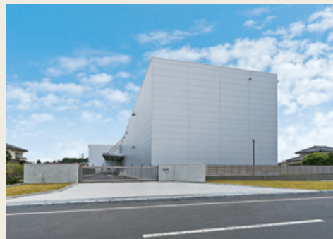
八街営業所 笹引2号倉庫
