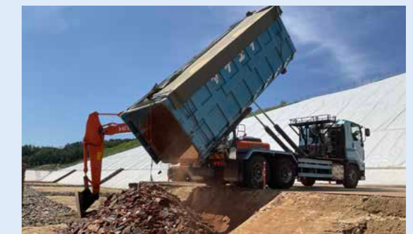
災害廃棄物受入れの様子
