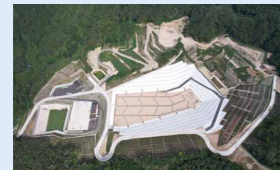
門前クリーンパーク管理型最終処分場(石川県輪島市)
