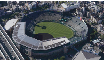
年間193,000kwhを発電し、球場内で使用する電力のうち約3.6%を賄っています。
