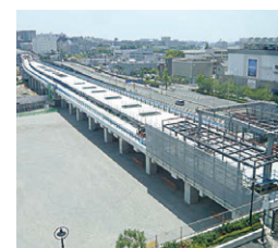
建設中の箕面菅野駅
