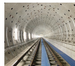
工事中のシールドトンネル内
