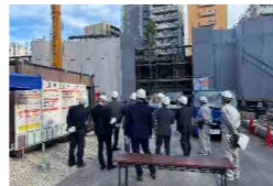
▲建物部会による安全巡視【マンション新築工事現場】(足場の設置やクレーン作業の状況確認)
