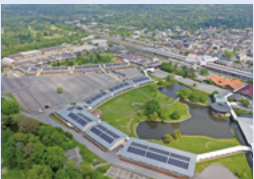
軽井沢・プリンスショッピングプラザ 太陽光発電システム
