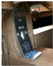
耐震補強金物を設置
