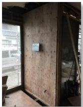
耐力壁の新設
