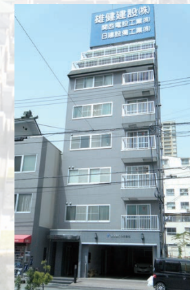
雄健建設(株)本社 外観
