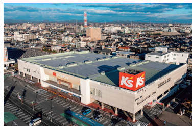
株式会社ベルモールへの太陽光パネル設置の様子
