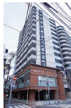
長崎支店、2026年3月完成。初の賃貸マンション併設型店舗
