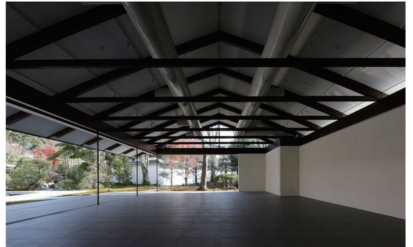
イノベーションリレーションシップセンター「下田黒船塾」 天井は黒船の船底を表現しています。スルガのDNAの原点ともいえる進取の精神をこのフリースペースで語り合いたい、という想いから設計されました。
