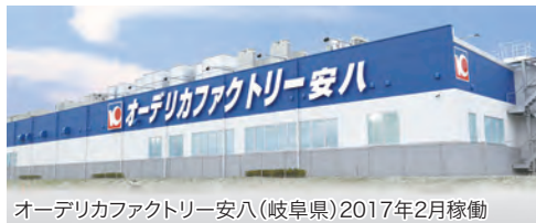
オーテリカファクトリー安八(岐阜県)2017年2月稼働
