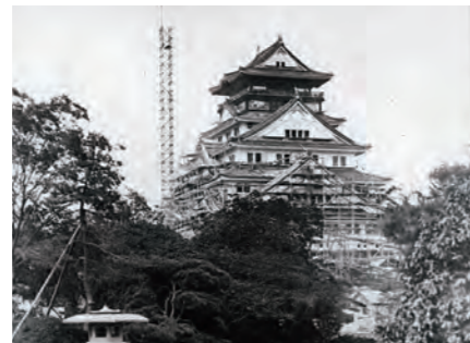
大阪城の天守閣のエレベーター工事が当社のエレベーター工事受注第1号となった。(1931年)
