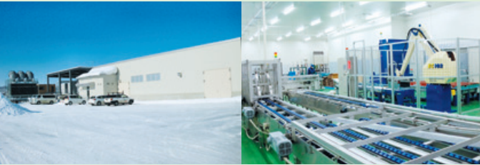
新冷凍工場の外観とコンベア設備
