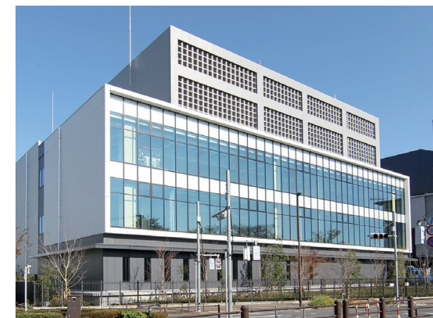
西東京データセンター
