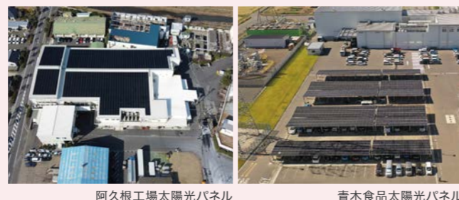
阿久根工場太陽光パネル
