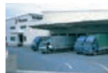
中央ロジスティックセンター
