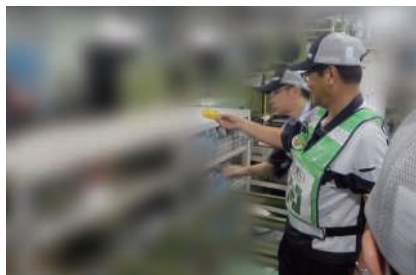
安全パトロールで現場確認を行う様子
