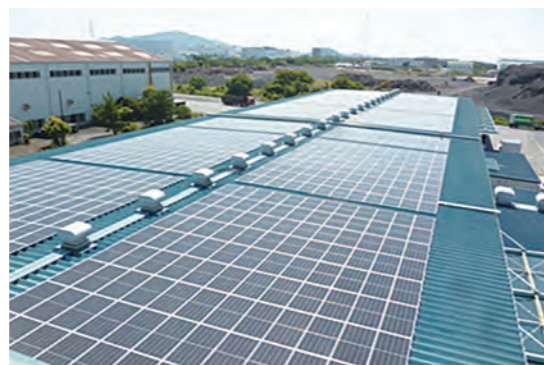
豊橋製造所 履帯工場屋根 (2025年7月稼働開始)
