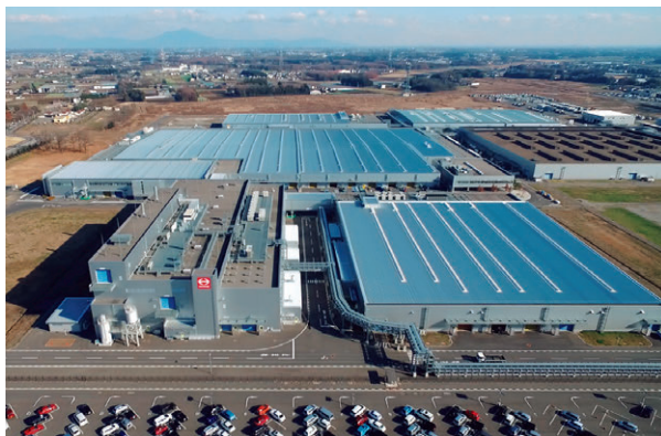
古河工場全景
