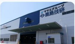
(株)鹿島技研 新本社工場
