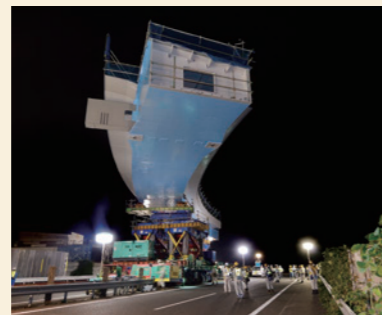
太田ジャンクションのキャリヤを用いた一括架設
