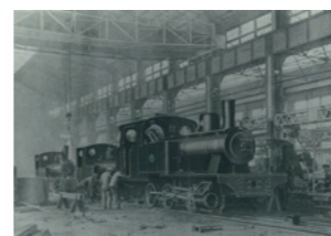
熱田本工場 機関車工場
