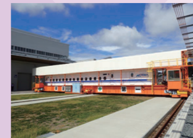
検修設備、車体トラバサ
