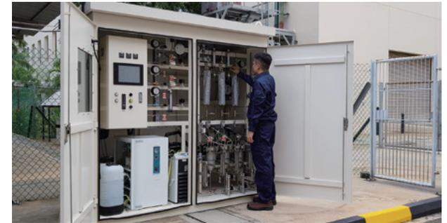
ISCE<sup>2</sup>内に設置しているメタネーション技術のデモ装置
