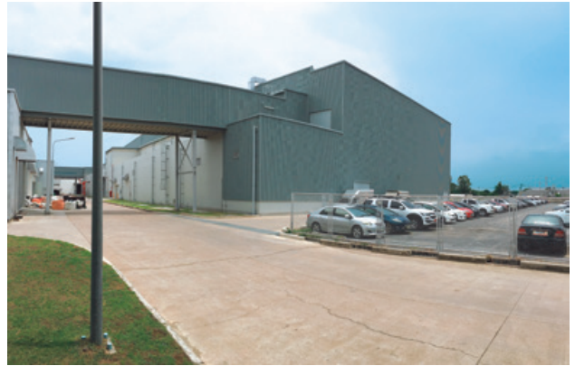
新たに増設した工場棟部分
