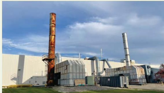
IISの構内の様子。統合した燃焼装置で基準値以下に無害化され、この煙突を介して大気へ放出される
