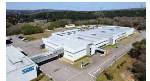
▲堀松工場B棟・先進技術推進センター 延床面積: 10,253.25m 2
