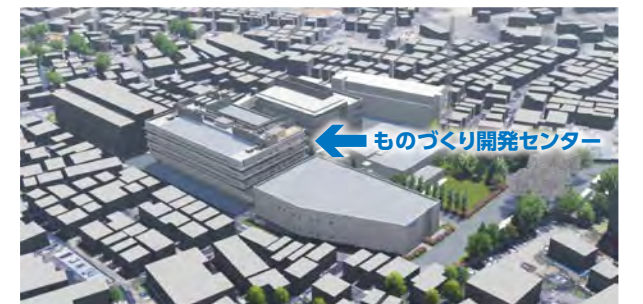
ものづくり開発センター外観(本社)
