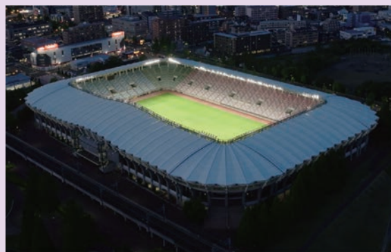
導入事例: ユアテックススタジアム
