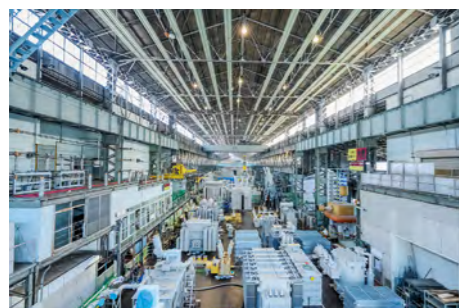
沼津事業所 変圧器工場
