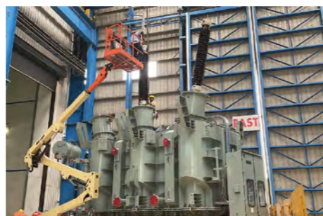
インド 変圧器組立ての様子
