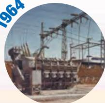
東海道新幹線の開通を支えた、国内最大級の30MVA移動用スコット結線変圧器。
