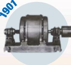
初めて製作した1HP三相誘導電動機。モートルの明電の始まり。
