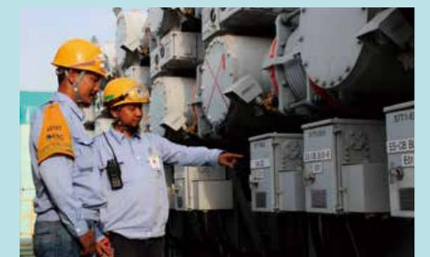
150kV ガス絶縁開閉装置 現地試験の様子
