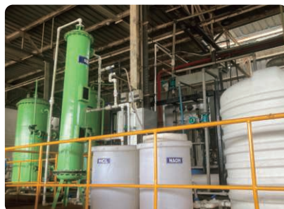
二層ろ過処理施設タンクと逆浸透膜処理施設 (NNMI・インド)
