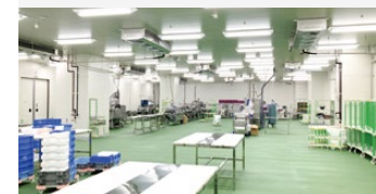
断熱パネル施工の様子
