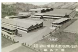
1950年代に新設された綱島工場
