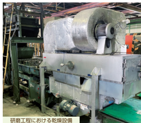
研磨工程における乾燥設備
