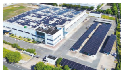
小森機械(中国・南通)の太陽光パネル
