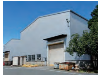
外壁に遮熱・断熱対策を施した工場
