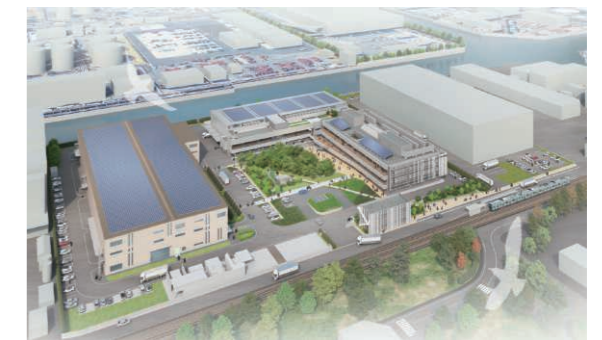
2027年2月に完成予定の当社・川崎製作所
