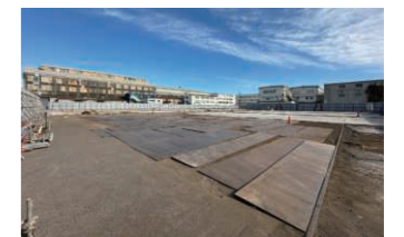
新たな施設が建設される旧第二工場跡地
