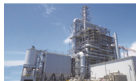
循環流動層(CFB)ボイラ
