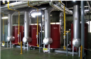
栃木工場：暖房ボイラーのガス化（重油廃止）
