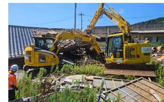
石川県輪島市の被災地で活躍する油圧ショベル * 画像提供：V ネット/ジャパンプラットフォーム
